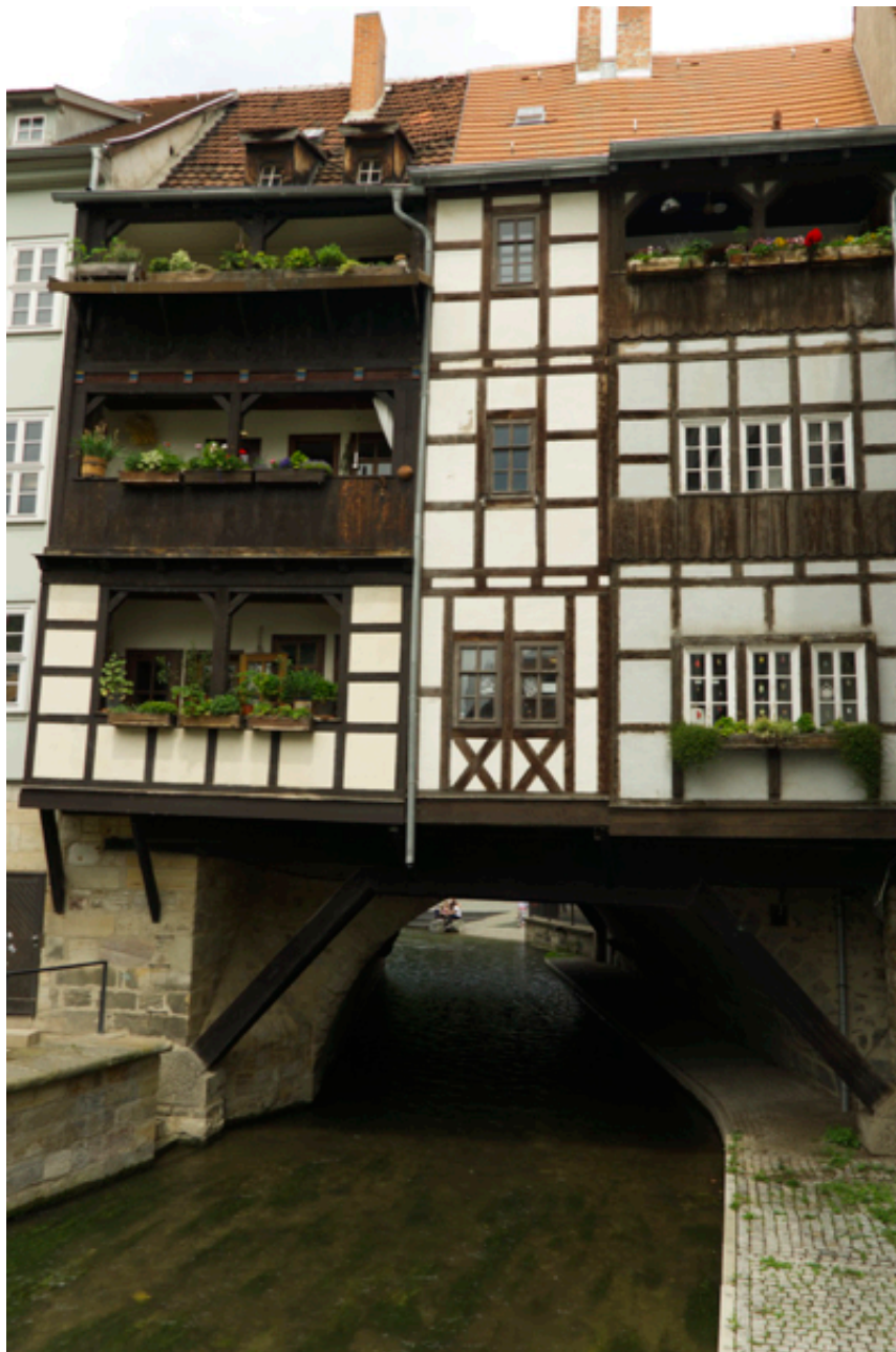
Rückseite der Krämerbrücke
