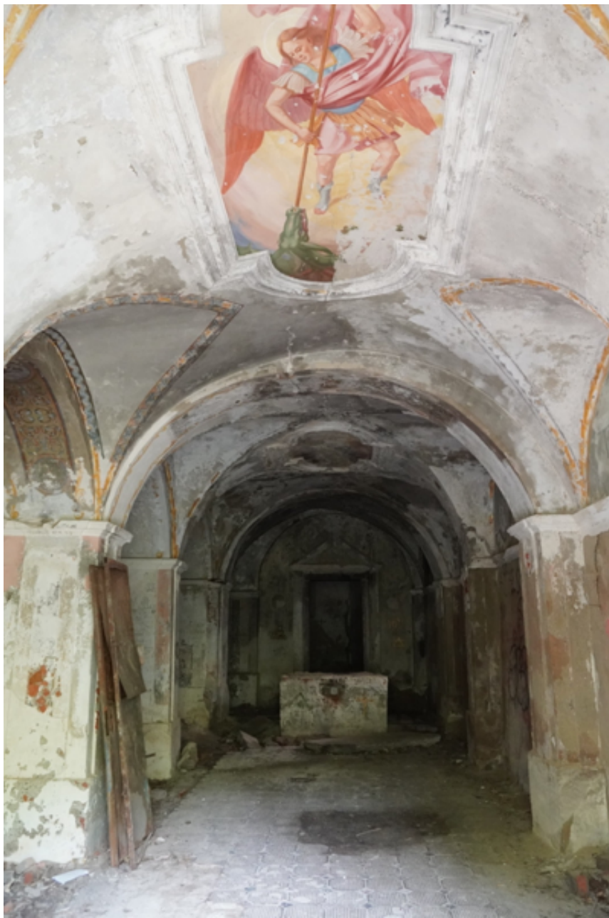
Ehemalige Kapelle der Kehlburg
